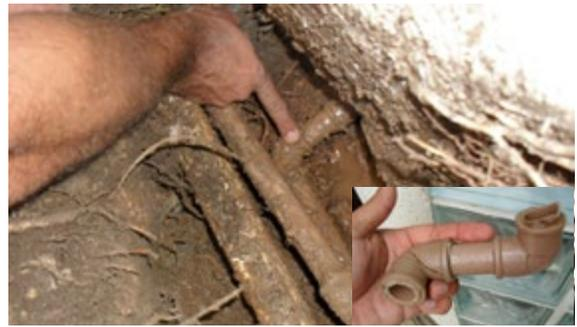
Figura 04: Encontrado el codo roto en la conexión
