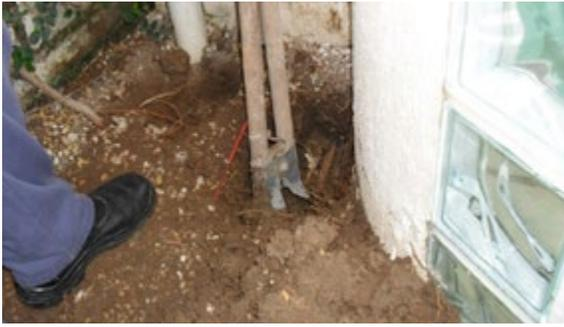
Figura 03: Excavación del lugar de la fuga
