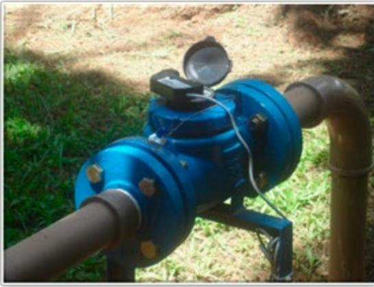
El medidor Multimag C&I ha operado cerca de un 46,5% del tiempo inferior al caudal de transición (Qt), región en que ocurren pérdidas por submedición.
